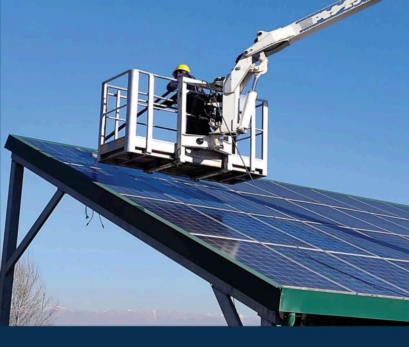
Effettuiamo un accurato lavaggio dei moduli con acqua ad osmosi inversa, ottenendo dal vostro impianto fotovoltaico una resa maggiore del 20%.
